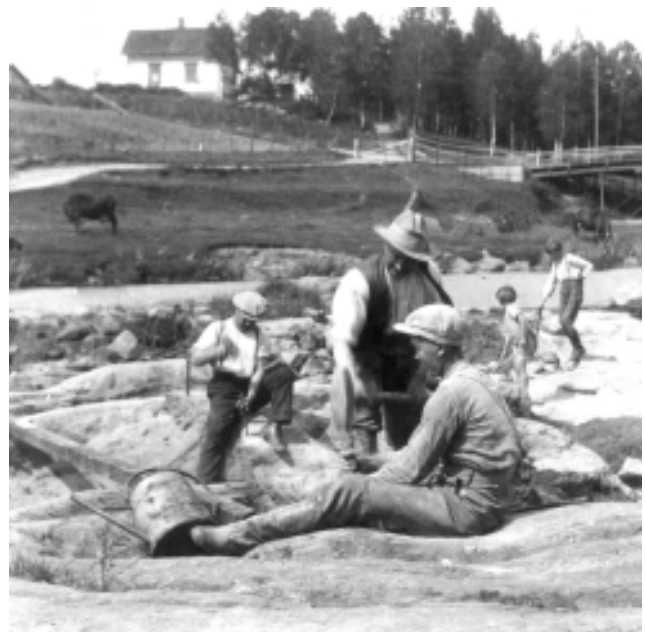
Padon rakennustyömaa Liedon Vääntelänkoskessa 1920-luvun lopussa. Kuva yksityiskokoelmasta.
