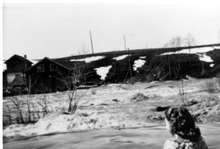
Keväätulva 1940-luvulla Liedon Vääntelänkoskessa. Vasemmalla mylly ja kuivurirakennus. Kuva yksityiskokoelmasta.
